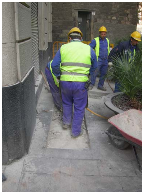
Fotografia núm. 25: Rasa 400, obrer treballant amb el martell compressor
