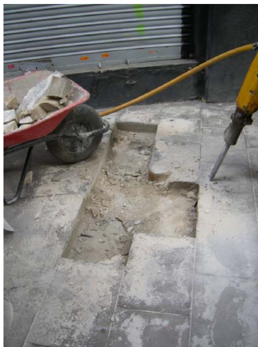
Fotografia núm. 23: Rasa 400, obrer treballant amb el martell compressor
