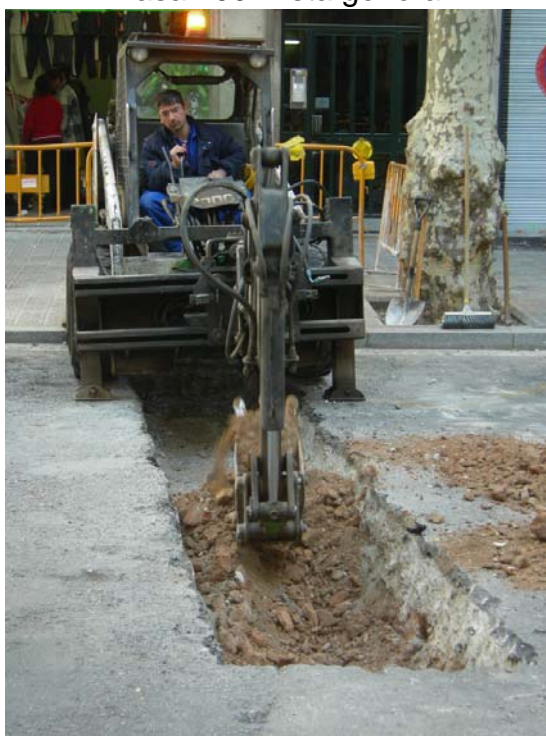
Fotografia 7: Rasa 200: Obrer obrint el Carrer Méndez Núñez amb la Bobcat, per poder passar la tubular.
