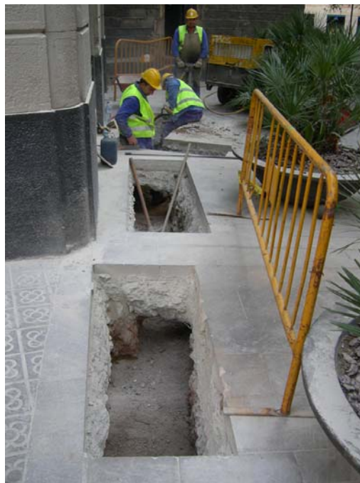
Fotografia núm. 27: Rasa 400, ja buidada fins a la cota màxima de profunditat.
