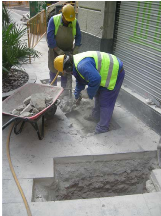
Fotografia núm. 26: Rasa 400, obrers treballant amb el martell compressor i la pala
