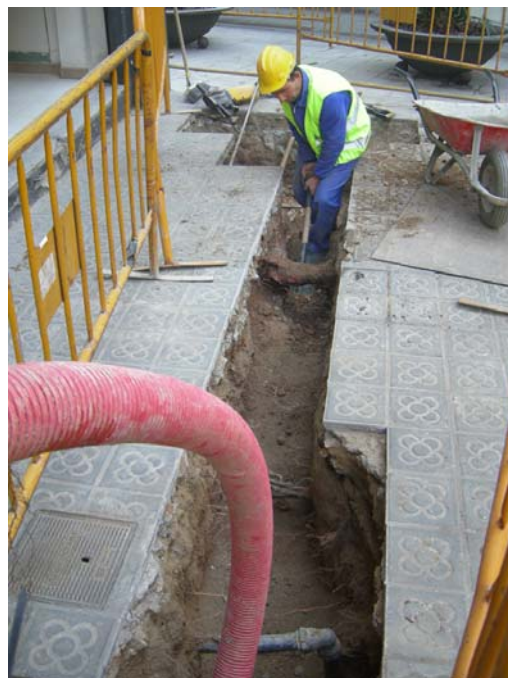
Fotografia núm. 19: Rasa 300, UE.310, i la rasa buidada fins a la cota màxima de profunditat, travessada per conduccions actuals
