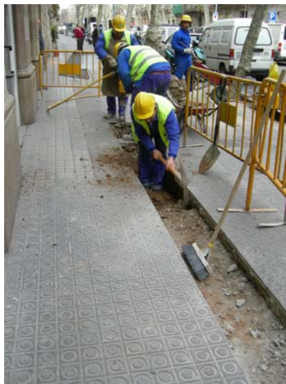
Fotografia núm. 2: Rasa 100, obrers treballant amb el martell compressor i el pic
